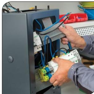
Inserta el kit de protección cableado en la base de fijación al suelo.
