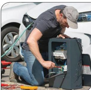
Instala la base de fijación al suelo precableada on-site.
